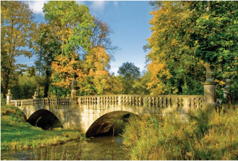
Abb. 9 Die „Muttone-Brücke“ im Klostergarten; Foto: Albert Schneider, Waldsassen.
